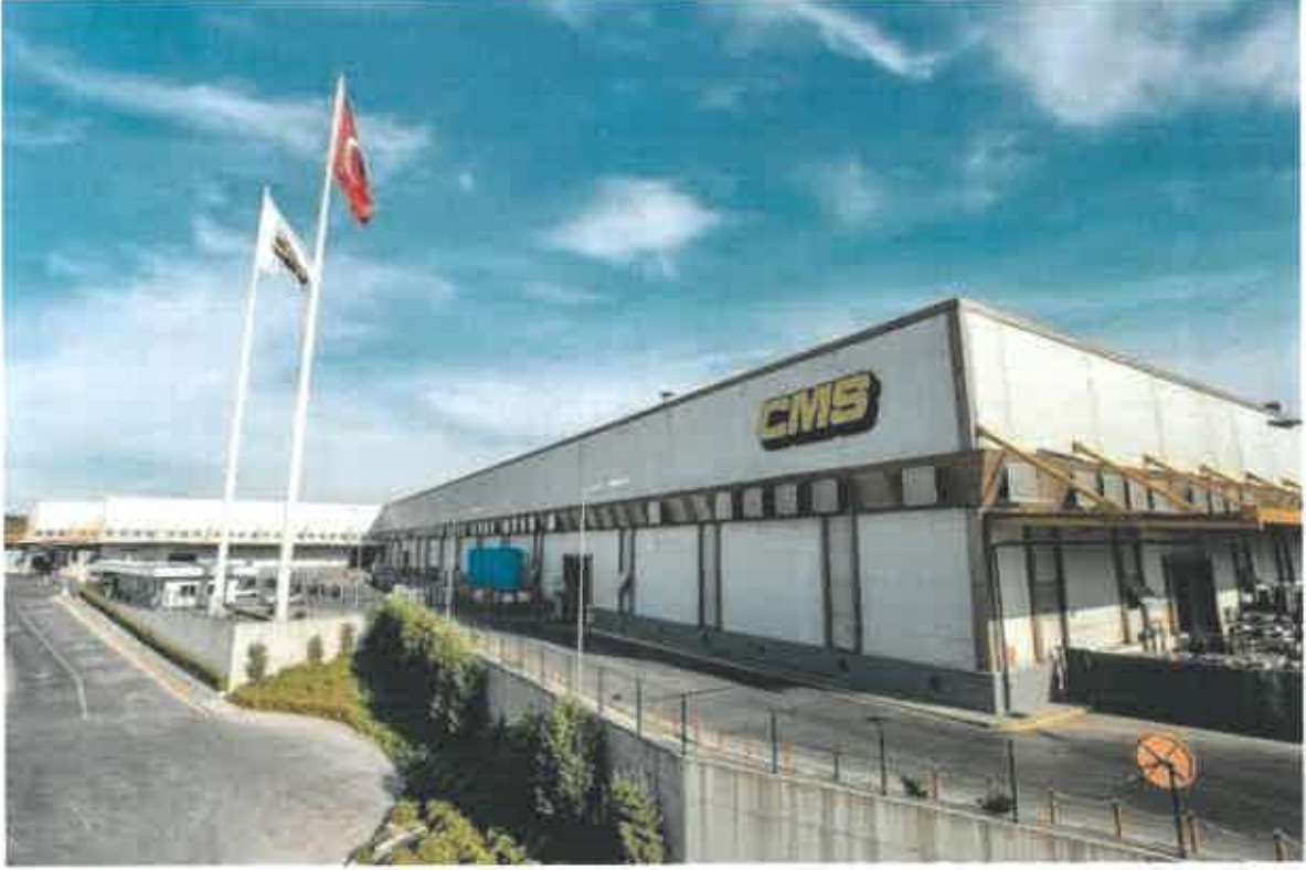
Görsel: Gaziemir Tesisi
